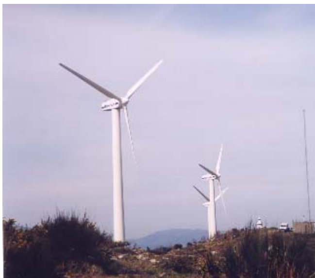
Figura 1.a: Fotografia de aerogeradores do Parque Eólico da Fonte da Mesa, situado na Serra das Meadas em Lamego.
